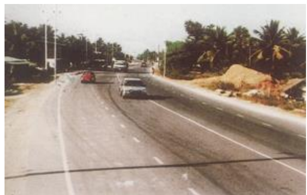
Đường 18B từ Áttapur (Lào) đến Kon Tum (Việt Nam) được xây dựng bằng vốn vay ưu đãi của Chính phủ Việt Nam, khánh thành ngày 15 tháng 4 năm 2006
