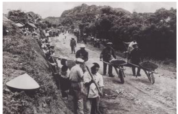
Công nhân Việt Nam cùng bộ đội và nhân dân Lào thi công đoạn đường Mường Liệt (từ Na Mèo, Thanh Hoá, Việt Nam) đi Sầm Nưa (Lào), năm 1963
