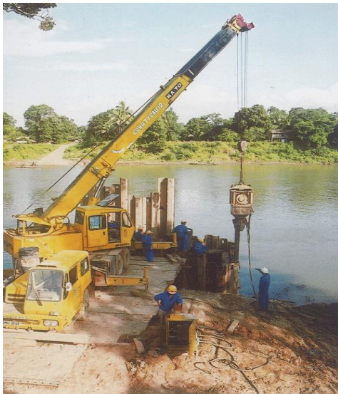
Công nhân Công ty cầu 12 (Việt Nam) thi công cầu Xê Coong tại Áttapur (Lào) thuộc Dự án đường 18B, được xây dựng bằng vốn vay ưu đãi của Chính phủ Việt Nam, khánh thành tháng 12 năm 2003
